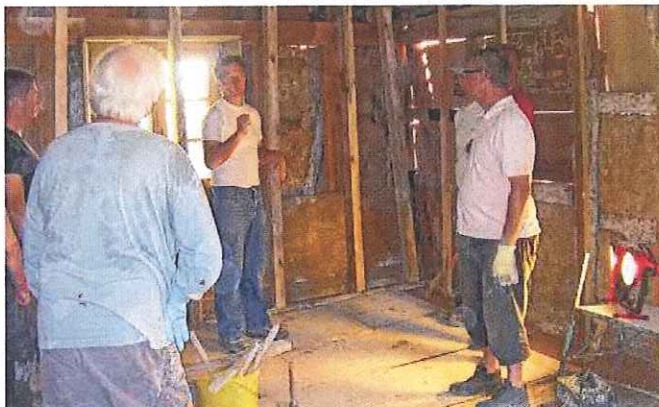
L'atelier d'apprentissage de l'utilisation du matériau chanvre. DOCUMENT REMIS
